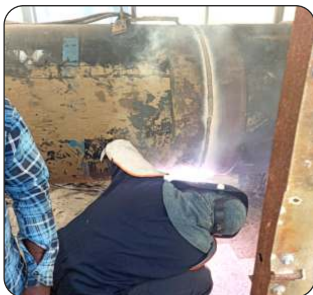
पाइपलाइन बिछाने का कार्य चल रहा है
